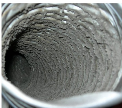
Figure 4 : Gain de distribution d'air non entretenues 4
