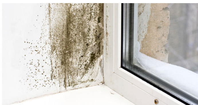
Figure 5 : Des traces de champignons dues à une mauvaise ventilation 5
