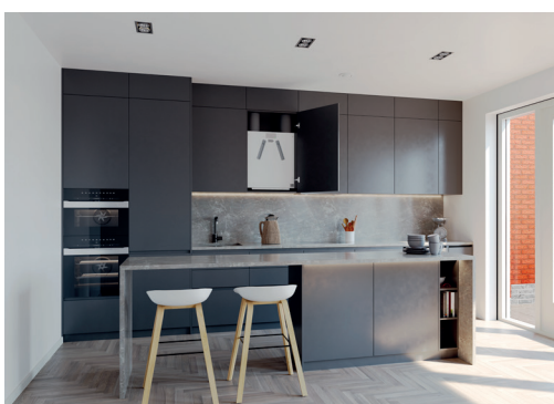
EASE 200 installé dans un placard de cuisine
