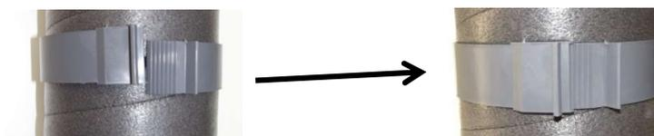
Serrer le clip du raccord afin de sceller le raccord aux gaines calorifugées EPE.
