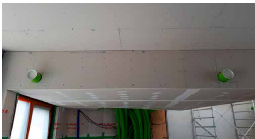
Réseau AE 48c vers les étages masqués dans l'habillage de la cage d'escalier.
