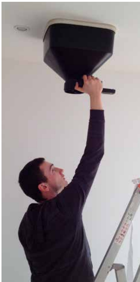
Mesure de débit avec un anémomètre sur cone de mesures pendant la mise en service de la VMC.
