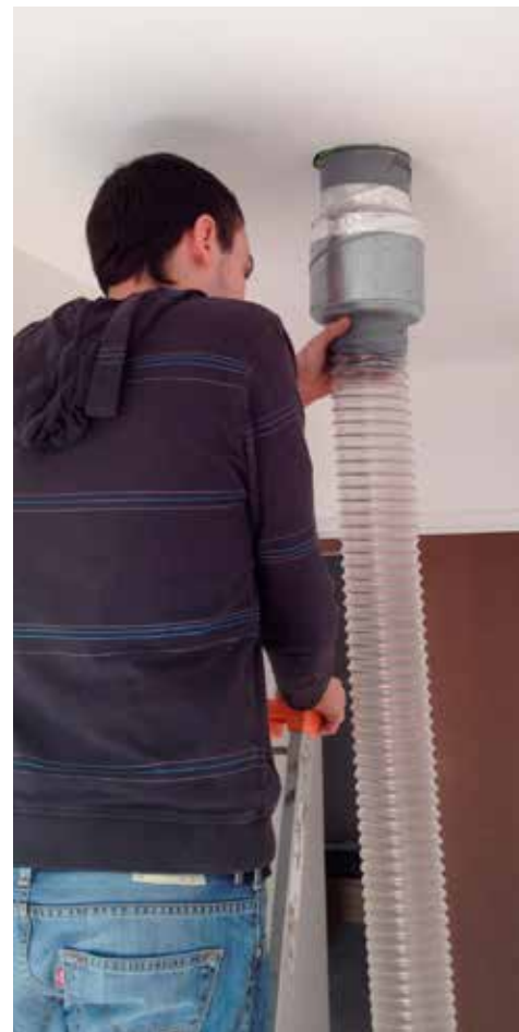
Test d'étanchéité à l'air du réseau de VMC double flux.
