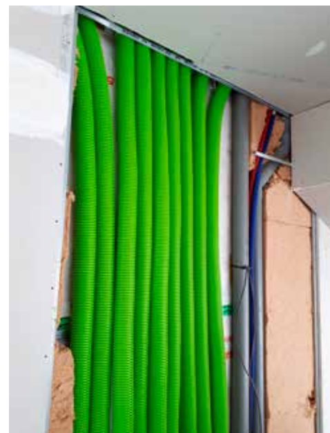
Réseau AE 48c vers les étages masqués dans l'habillage de la cage d'escalier.
