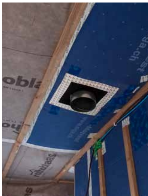
L'étanchéité à l'air est soignée autour de la bouche d'évacuation.
