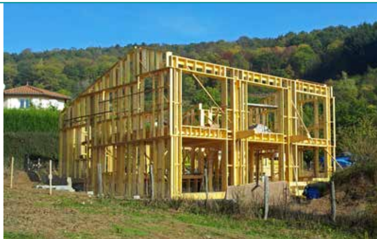
L'ossature double en pin massif de la maison.
