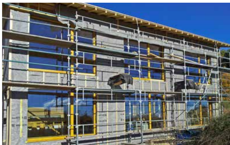
Derrière le pare-pluie, différentes épaisseurs de ouate de cellulose ont été insufflées, un débord de façade permettant de masquer les rails des volets coulissants.
