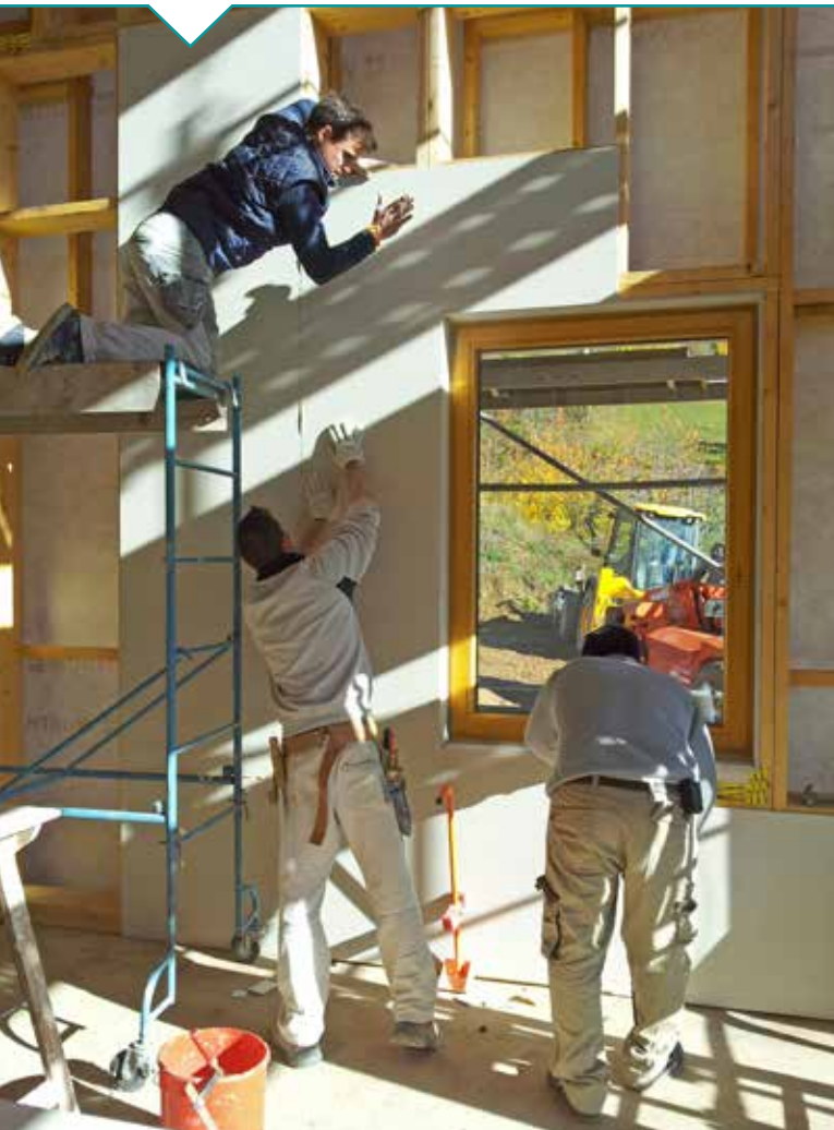
Les panneaux de Fermacell assurent 5 fonctions à eux seuls : parement intérieur, contreventement, frein-vapeur, étanchéité à l'air et apport d'inertie.
