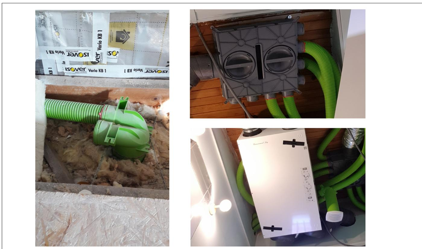
“ J’ai décidé d’installer une VMC double flux dans cette maison en rénovation pour assurer des renouvellements d’air suffisants et réduire la déperdition du poste ventilation. C’est le groupement d’artisans spécialisés en rénovation énergétique auquel je suis adhérent qui m’a fait connaître la marque Brink.
