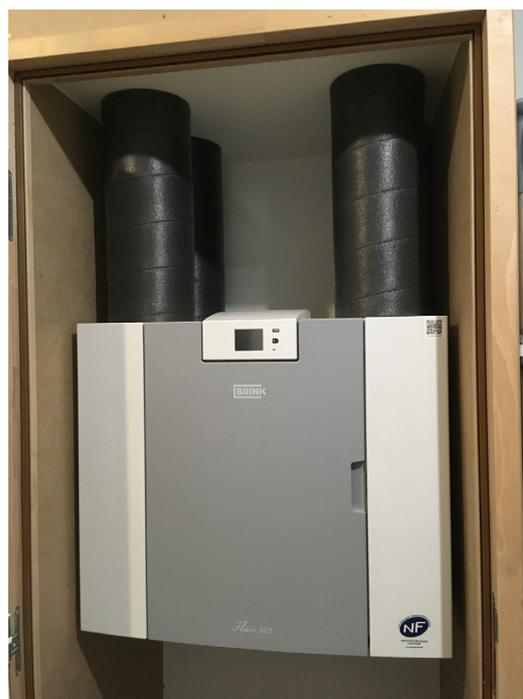
“ Sur ce chantier, une centrale de VMC double flux d'une autre marque était déjà installée depuis quelques années. Défectueuse (ventilateurs HS) et très bruyante, les utilisateurs m'ont demandé de la remplacer. J'ai choisi une centrale de VMC double flux dernière génération de la marque Brink, la Flair 325.
