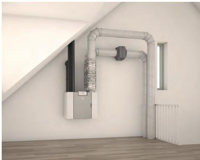
Installé dans la gaine de l'unité de ventilation à destination des pièces du logement, l'Evap devient un composant intégral de votre système de ventilation.
