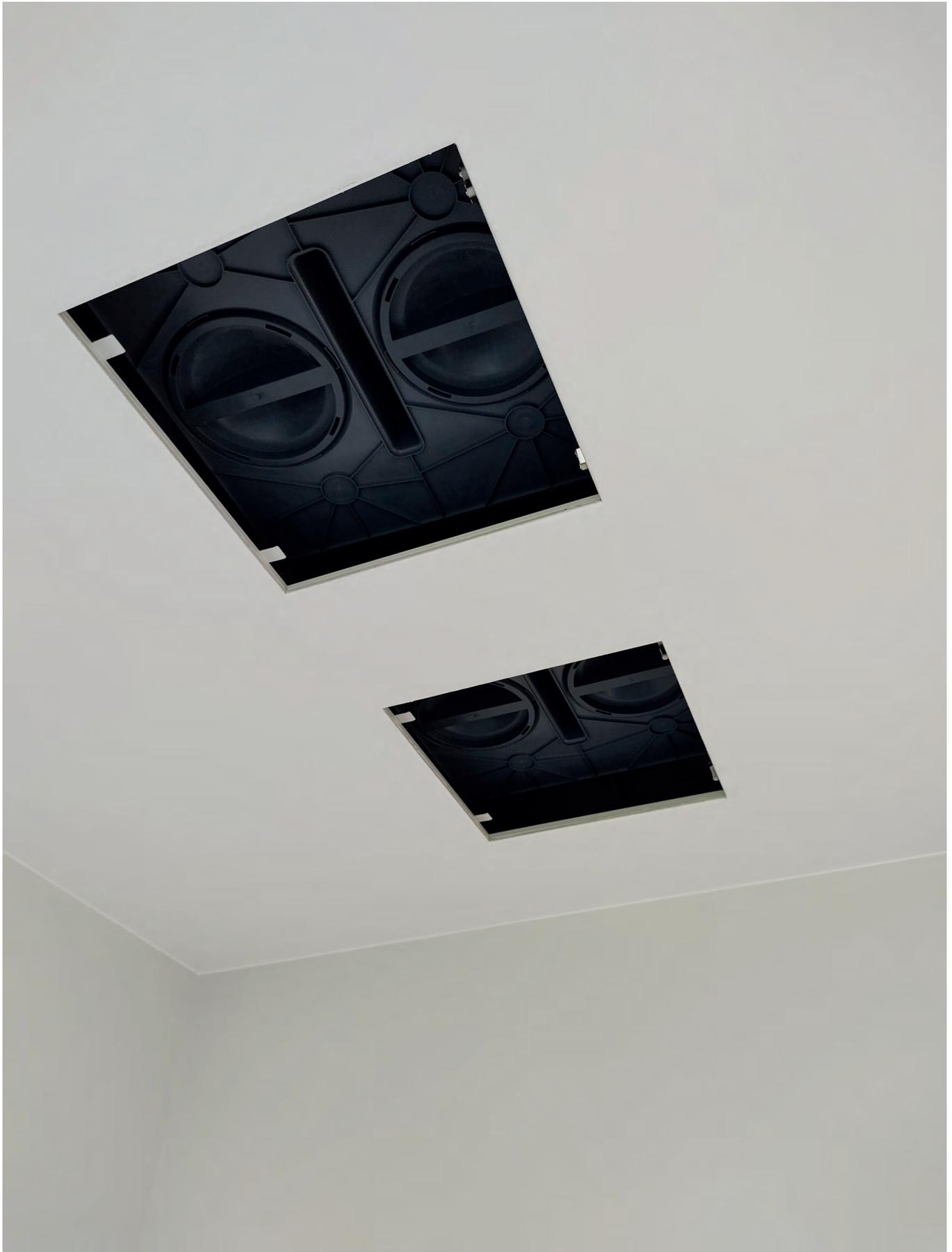
>> Trappes d'accès pour maintenance des caissons de distribution d'air
