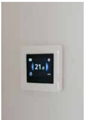
Chaque bouche chauffante est contrôlée par un thermostat d'ambiance simple d'utilisation. A droite, l'intérieur d'une bouche chauffante.
