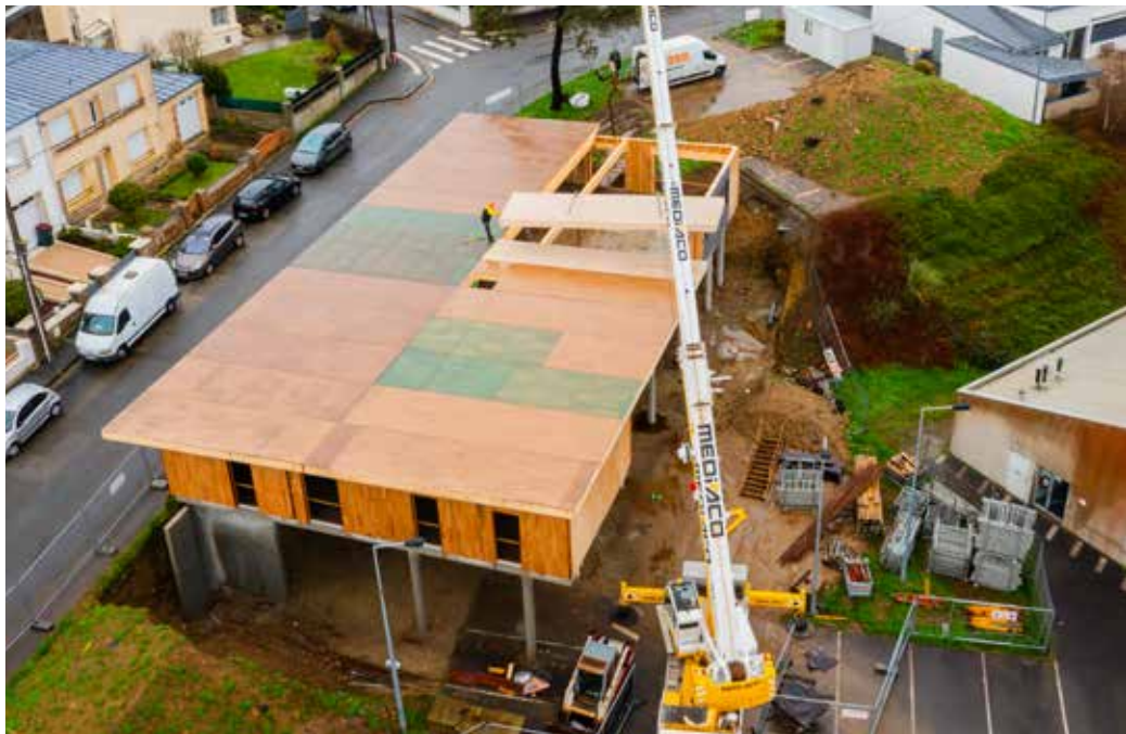
Le bâtiment est hors d'eau hors d'air en quelques jours, laissant la place pour le second œuvre.
