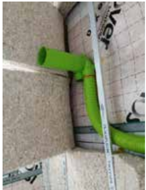
Les gaines sont en PEHD de qualité alimentaire, garanties d'un air sain.
