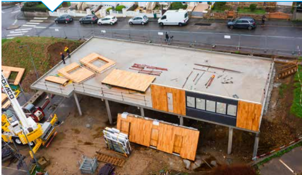
Entièrement préfabriqués en atelier chez GLV, les panneaux sont rapidement assemblés sur la dalle isolée.
