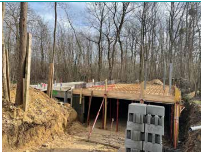
Le garage enterré est en béton, mais la partie double pan est construite sur pieux pour minimiser l'empreinte de la construction, épargner les racines et faciliter l'infiltration de l'eau de pluie sur la parcelle.
